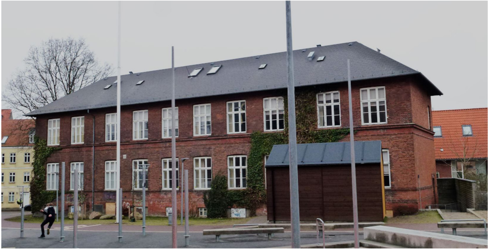
Facade mod Frederiksbjerg Skole
